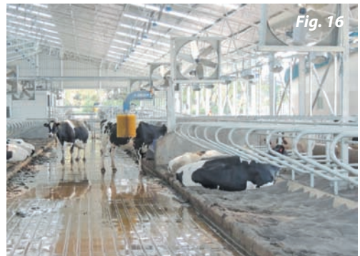
Figura 15 y 16: Sistema de ventilación forzada en la zona de camas
