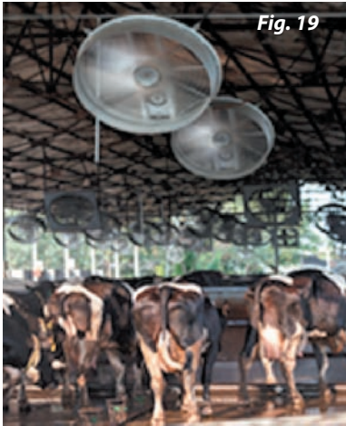
Figura 19 y Esquema: Planificación de la instalación de un sistema de enfriado de vacas en el patio de espera.
