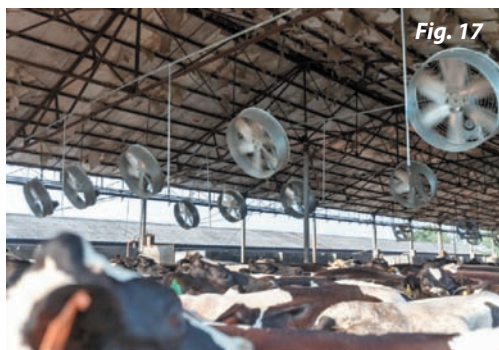
Figura 17 y 18: Sistema de Ventilación + Aspersión a nivel del patio de espera
