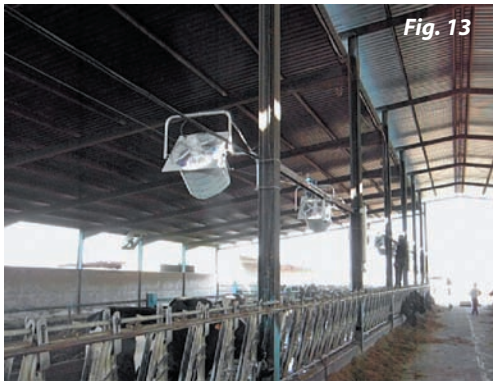
Figura 13 y 14: Sistemas de Ventilación + Aspersión a nivel del comedero
