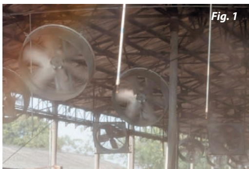
Figura 1 y 2. Sistema de enfriamiento directo (mojado sobre el animal más ventilación forzada)
