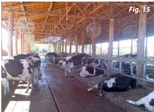
Figura 15 y 16: Sistema de ventilación forzada en la zona de camas
