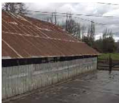
Foto 1.3. Techos sin canalización independiente de aguas lluvia.
