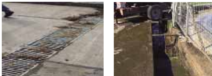
Foto 4.1. Rejillas para evitar el ingreso de residuos de forraje y material extraño al pozo purinero.
