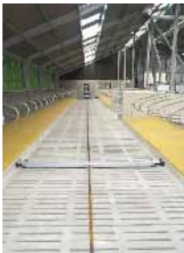
Foto 5.4. Raspador con cable sobre piso de concreto.
