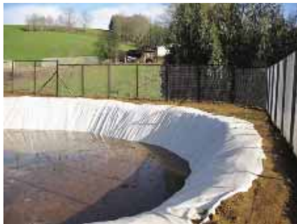
Foto 4.11. Pozo sellado con PVC.
