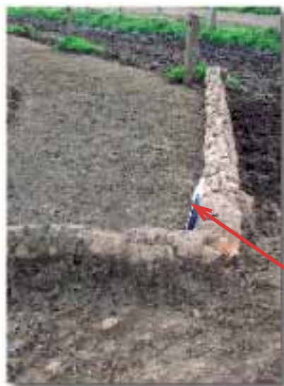
Foto 4.3. Barrera para evitar la entrada de piedras y arena al callejón de cemento.
