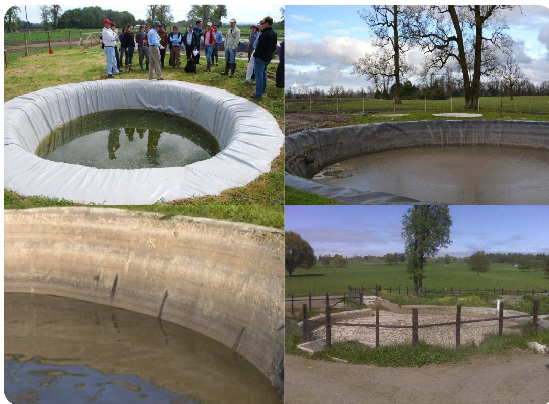
Figura 4. Materiales de construcción y sellado de pozos de almacenamiento de purines: PVC, poliestireno de alta densidad (PEAD), estucado ('chicoteado') con malla y cemento, y pozo de hormigón.
