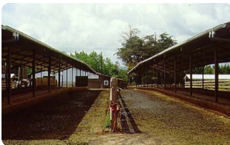
Figura 3. En zonas de alta pluviometría es muy importante canalizar aguas lluvia en épocas de alta pluviometría hacia drenajes externos, evitando el ingreso a pozos de almacenamiento de purines.
