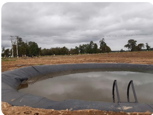
Figura 8. Pozo de poliestireno de alta densidad con escalera de seguridad.
