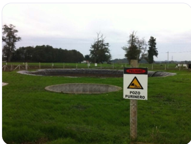
Figura 7. Pozo purinero debidamente cercado perimetralmente y señalizado, restringiendo el acceso de personal no autorizado.
